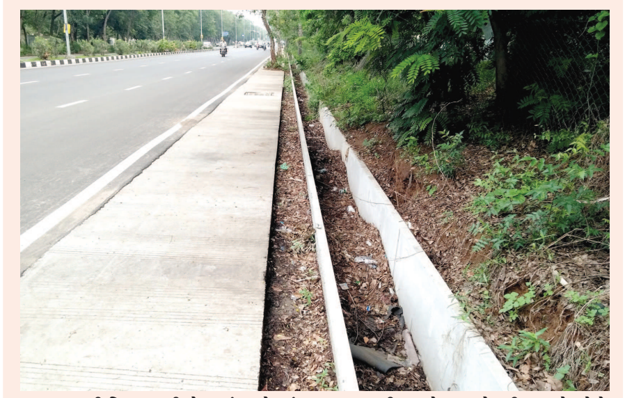
વરસાદી સિઝન જામી છે. જ્યાં જુઓ ત્યાં વરસાદના પાણી ભરાયેલા નજરે ચઢી રહ્યા છે. જો કે શહેરમાં પાણીના નીકાલ માટે સારી વ્યવસ્થા ગોઠવાઈ હોવાથી વરસાદ પડ્યા બાદ ખૂબ ઓછા સમયમાં પાણી ઉતરી જાય છે. ગ-૨૦૬ ઉપર વરસાદી પાણીના નીકાલ માટે બનાવવામાં આવેલી કેનાલમાં કચરો ભરાઈ રહે છે. પાણીના નીકાલ માટેની આ નીકને કચરાપેટી બનાવી દેવાઈ હોય તેવું લાગી રહ્યું છે.
