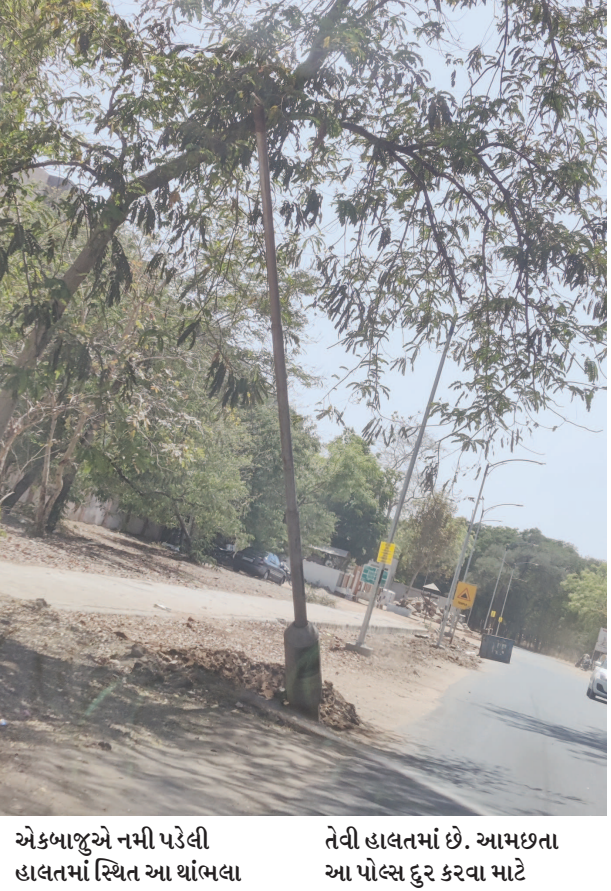
એકબાજુએ નમી પડેલી હાલતમાં સ્થિત આ થાંભલા તેવી હાલતમાં છે. આમ છતાં આ પોલ્સ દુર કરવા માટે
