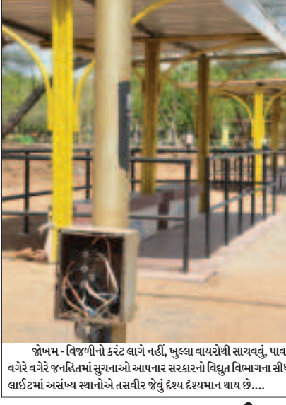
જોખમ - વિજળીનો કરંટ લાગે નહીં, ખુલ્લા વાયરોથી સાચવવું, પાવર જનરેશનની આસપાસ રહેવું નહીં વગેરે વગેરે જનહિતમાં સુચનાઓ આપનાર સરકારનો વિદ્યુત વિભાગના સીધા નિયંત્રણ હેઠળ ગાંધીનગરની સ્ટ્રીટ લાઈટમાં અસંખ્ય સ્થાનોએ તસવીર જેવું દેશ્ય દેશ્યમાન થાય છે.... (તસવીર : દિપક જાની)
