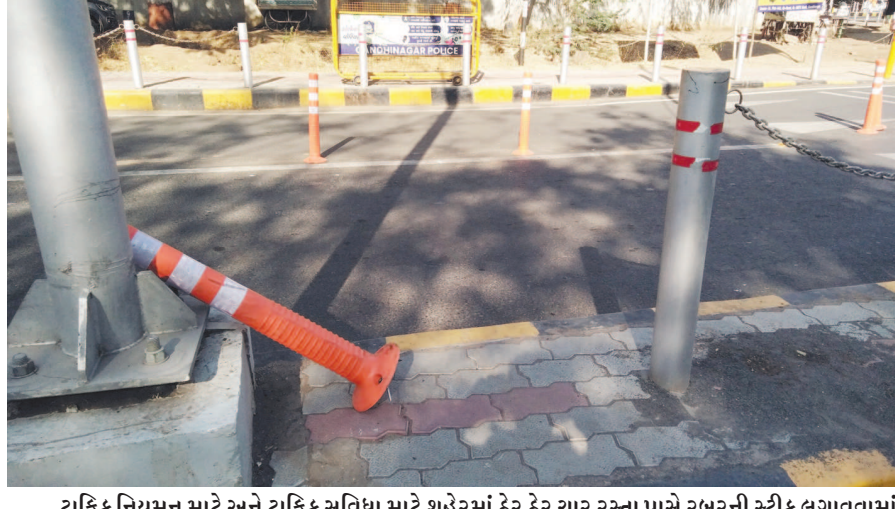
ટ્રાફિક નિયમન માટે અને ટ્રાફિક સુવિધા માટે શહેરમાં ઠેર ઠેર ચાર રસ્તા પાસે રબરની સ્ટીક લગાવવામાં આવી છે. જો કે આ સ્ટીક વધુ ગતિથી આવતા વાહનો માટે અડચણરૂપ બને છે. વાવોલથી ઘ-૩ સર્કલ જવાના માર્ગે લગાવેલી ટ્રાફિક નિયમન સ્ટીક કોઈએ ઉપેડી નાંખી છે અથવા તો કોઈ વાહનની અડકેટે આવીને ટુટીને ફેંકાઈ ગઈ છે.
