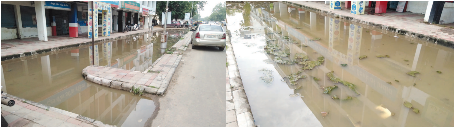
સેક્ટર-૧૬માં બેંક વિસ્તારની આગળ પાર્કિંગ સ્પેસ બનાવવામાં આવી છે. પાર્કિંગ માટેની આ જગ્યા મુખ્ય માર્ગથી નીચાણવાળા ભાગમાં છે. વળી અહીં વરસાદી પાણીના નિકાલ માટે કોઈ વ્યવસ્થા કરવામાં આવી ન હોવાથી ચોમાસામાં અહીં પાણી ભરાઈ જાય છે. લાંબા સમય સુધી અહીં પાણી ભરાઈ રહેતું હોવાથી અહીં લીલ પણ જામી ગઈ છે. જેના કારણે મચ્છરોનો ઉપદ્રવ વધવાની સંભાવના છે.
